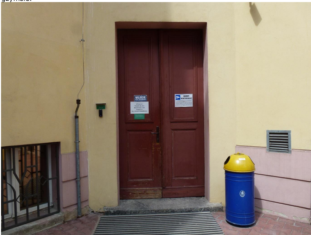
Fot.5.0 – Elewacja południowo-wschodnia od podwórza – drzwi wejściowe w złym stanie technicznym , nieszczelne skrzydła mocno zdeformowane (po zamknięciu powstają duże szczeliny) Drzwi nie posiadają elementów stanowiących wartości historyczną.
