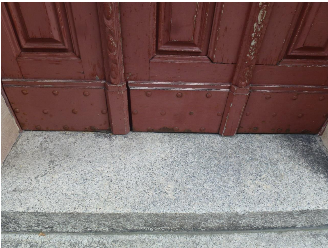
Fot. 1.2 – Elewacja zachodnia portal wejścia do budynku - uszkodzenia na powierzchni drzwi: złuszczenia farby spękania na łączeniach, korozja dolnej blachy osłonowej.
