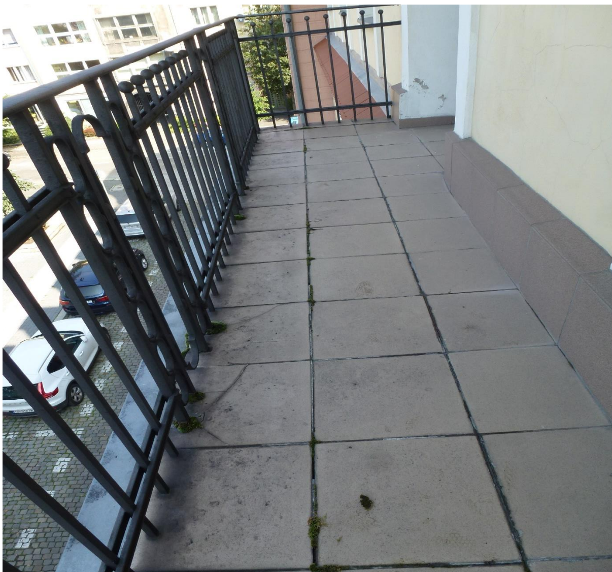
Fot.1.13 – Elewacja zachodnia – popękane oraz odspojone od podłoża płytki gres, porosty mchu między spoinami na balkonie II piętra, skorodowana miejscowo balustrada balkonu.
