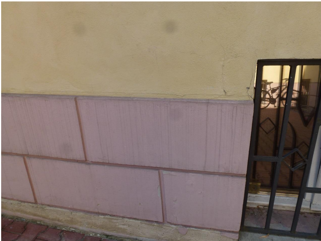
Fot.3.6 – Elewacja wschodnia od strony podwórza – ubytki farby na cokole boniowanym w strefie przyziemia, zacieki brudu i spękania na ścianach
