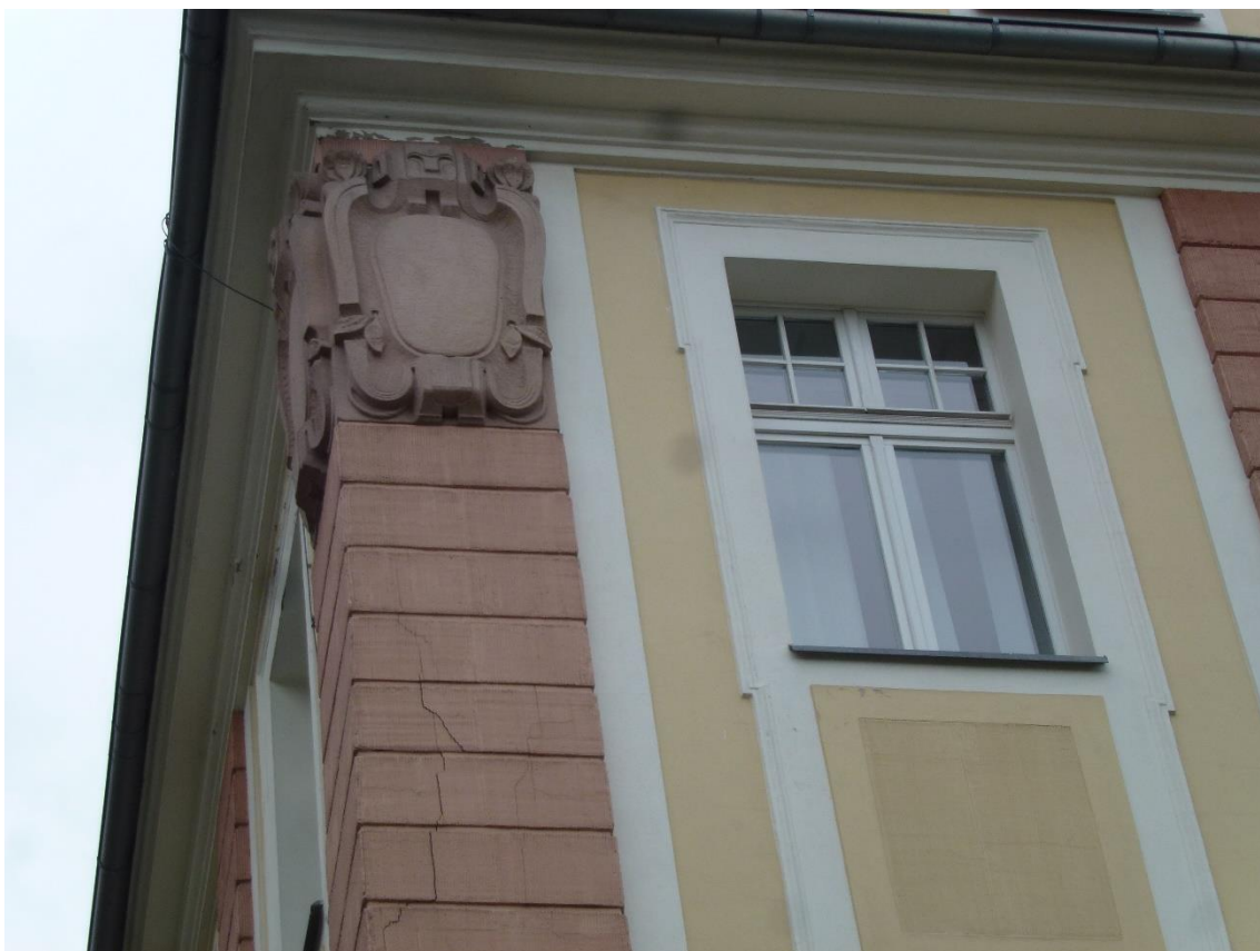
Fot.1.11 – Elewacja zachodnia – spękania na tynku pilastru narożnego.
