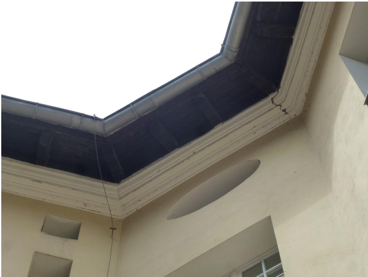
Fot.4.4 – Elewacja południowo-wschodnia od podwórza – ubytki i złuszczenia farby na gzymsie.
