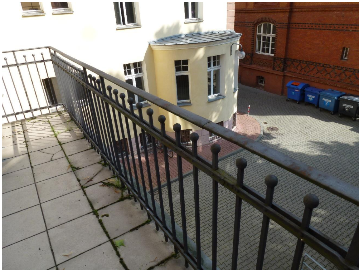
Fot.3.4 – Elewacja wschodnia ściana od podwórza – popękane oraz odspojone od podłoża płytki gres, porosty mchu i trawy między spoinami na balkonie II piętra, skorodowana miejscowo balustrada balkonu, nieszczelna obróbka.
