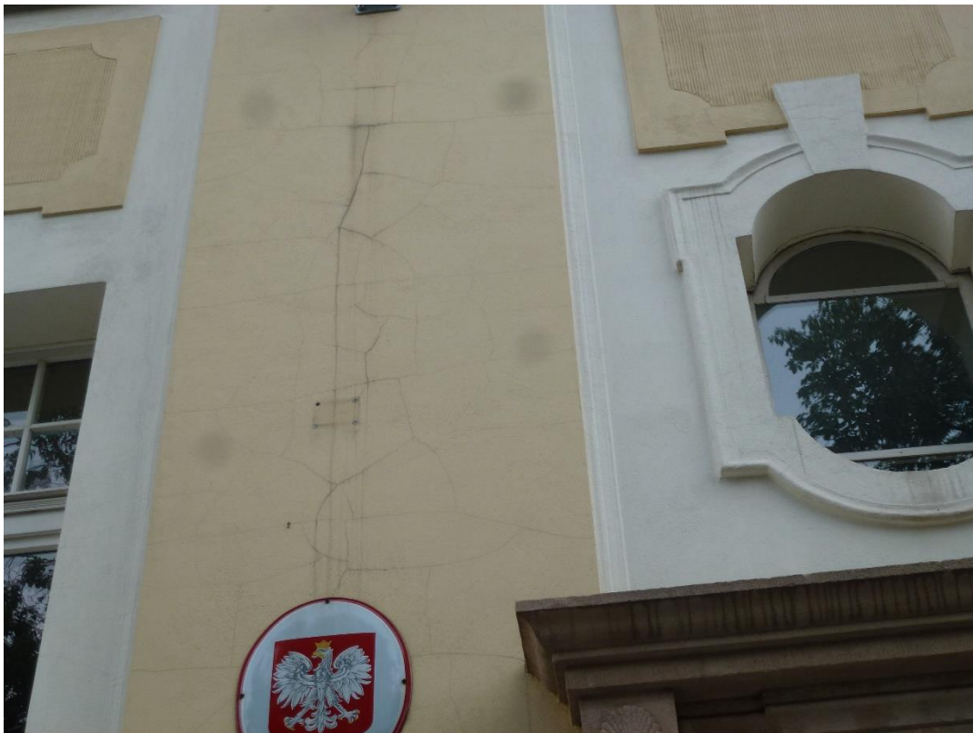
Fot. 1.4- Elewacja zachodnia – liczne spękania włoskowate i szczeliny na tynkach gładkich elewacji oraz kurz i zacieki brudu na obramieniach okiennych.
