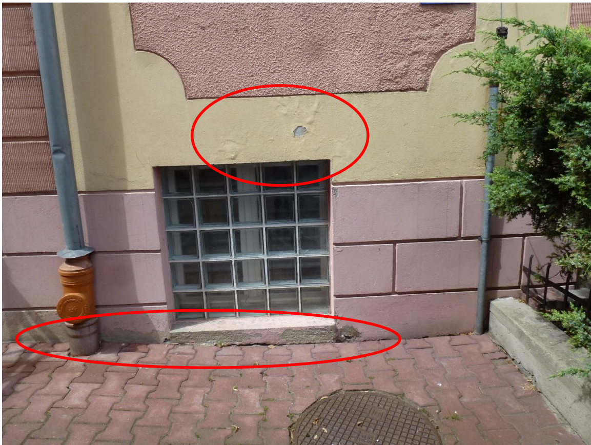
Fot.3.2 – Elewacja wschodnia ściana szczytowa – spuchlizny, ubytki farby i złuszczenia na tynku gładkim i tynku boniowanym cokołu.
