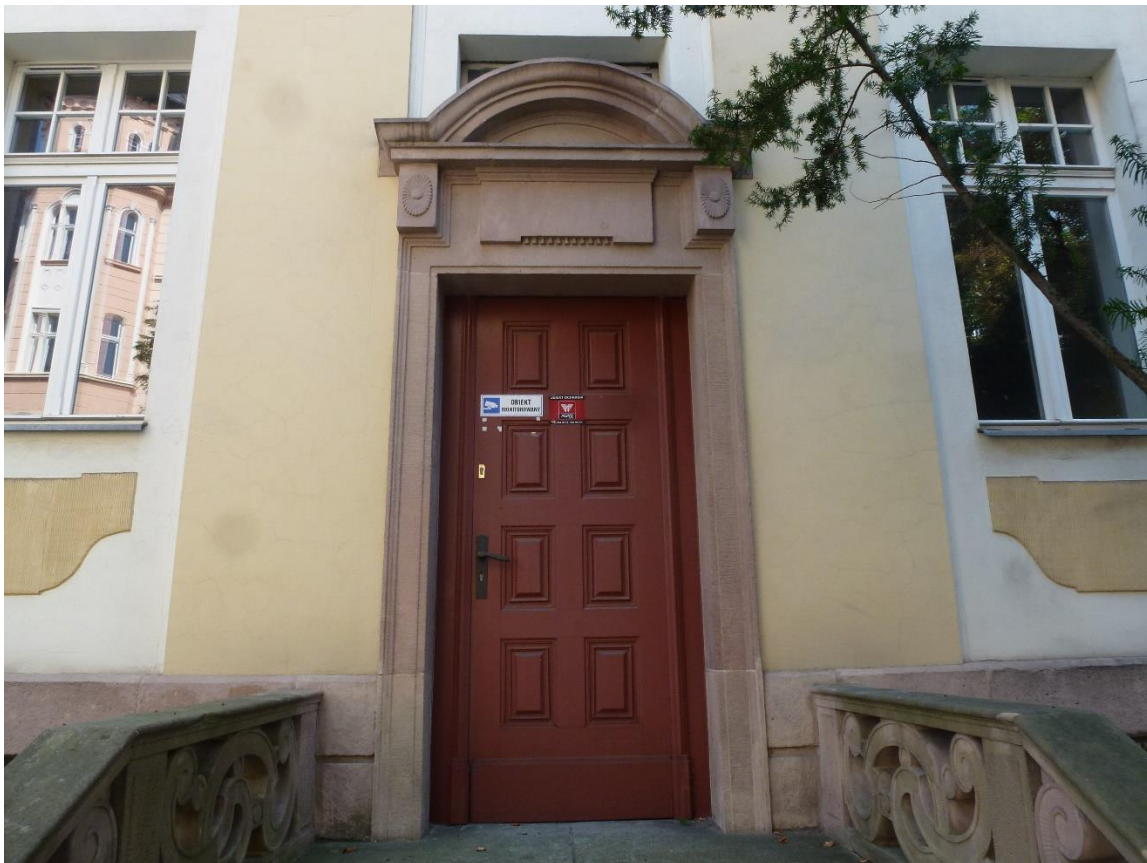
Fot.2.8 – Elewacja północna od strony ul. Tadeusza Kościuszki – zacieki brudu z sadzą na kamiennych elementach portalu, drzwi – wypłowiła farba na powierzchni od działania warunków atmosferycznych
