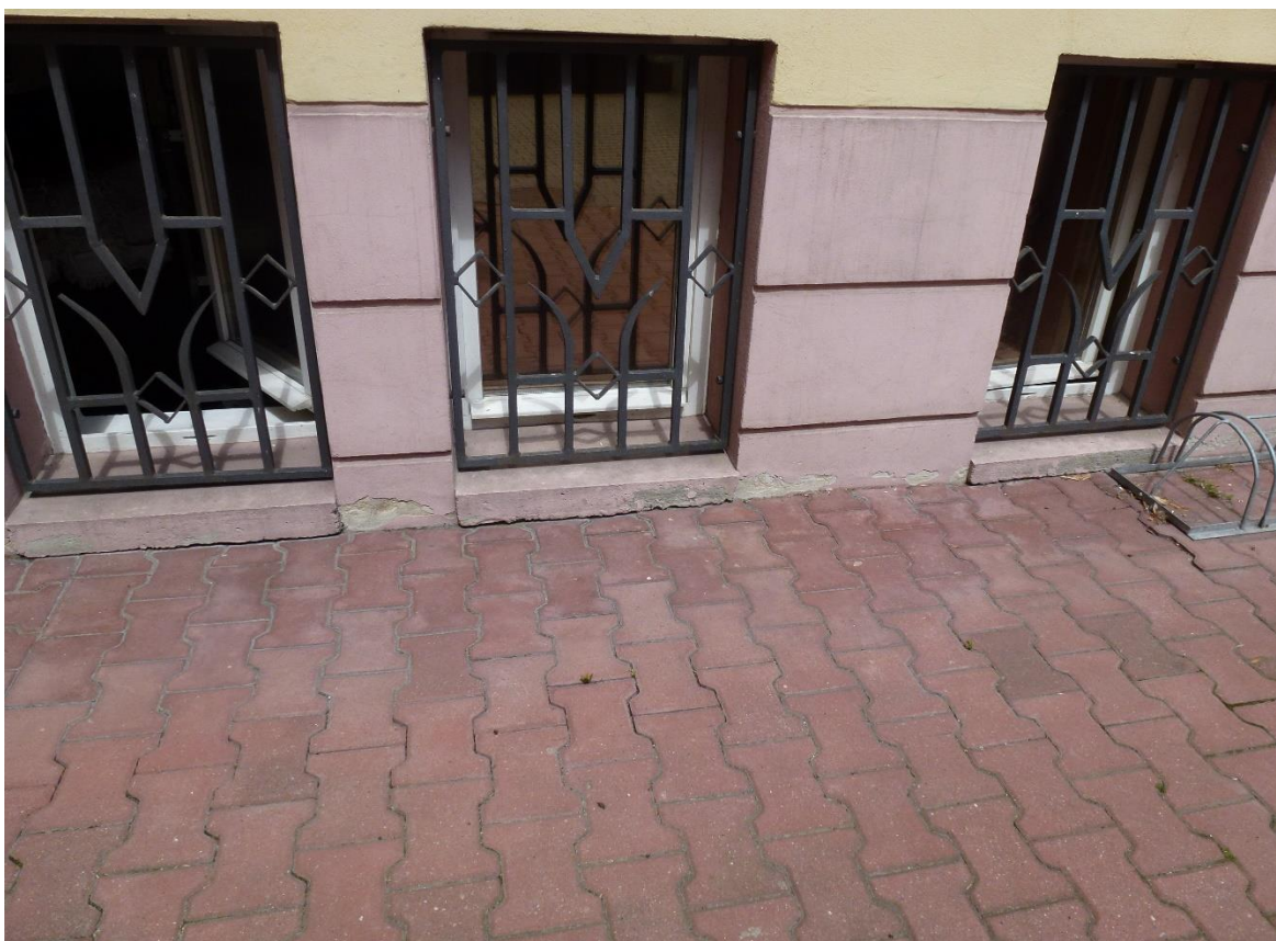
Fot.4.1 – Elewacja południowa od podwórza – ubytki tynku i farby na cokole w strefie przyziemia , miejscowo skorodowane kraty okienne, brudne zacieki na ścianie i cokole.
