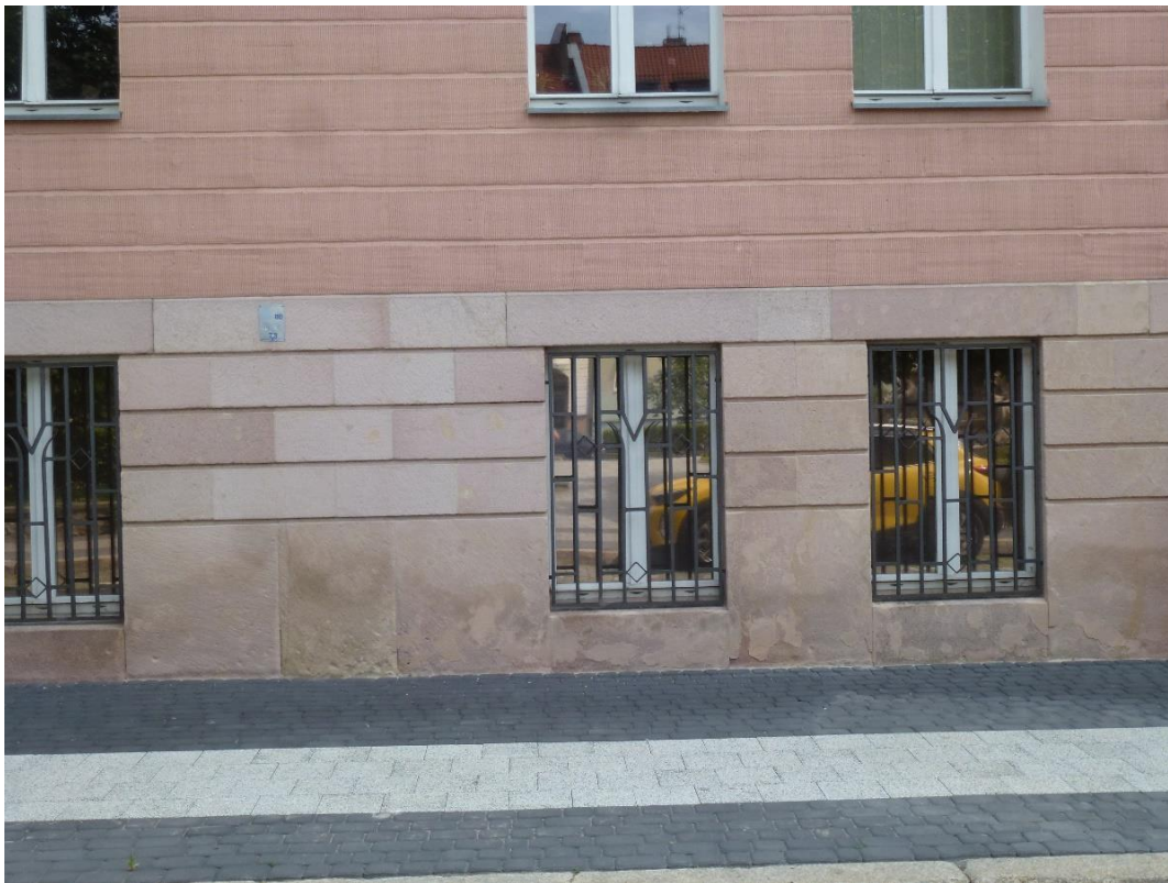
Fot.1.8 – Elewacja zachodnia – miejscowe ubytki, plamy, przebarwienia oraz oderwane płyty szpachli w strefie przyziemia na cokole z piaskowca różowego.
