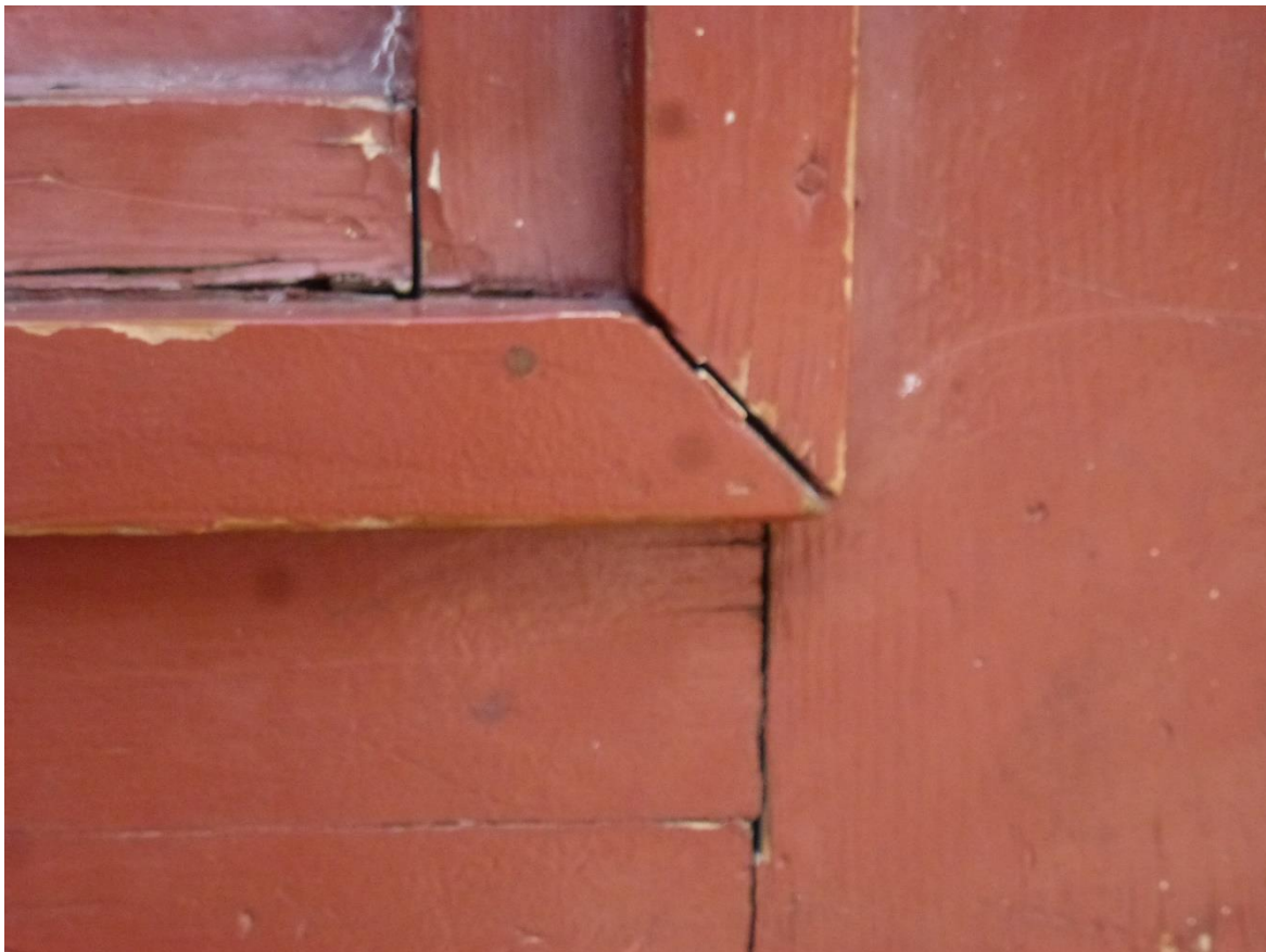
Fot.5.1 – Elewacja południowo-wschodnia od podwórza – drzwi wejściowe w złym stanie technicznym , widoczne spękania i zeschnięcia elementów
