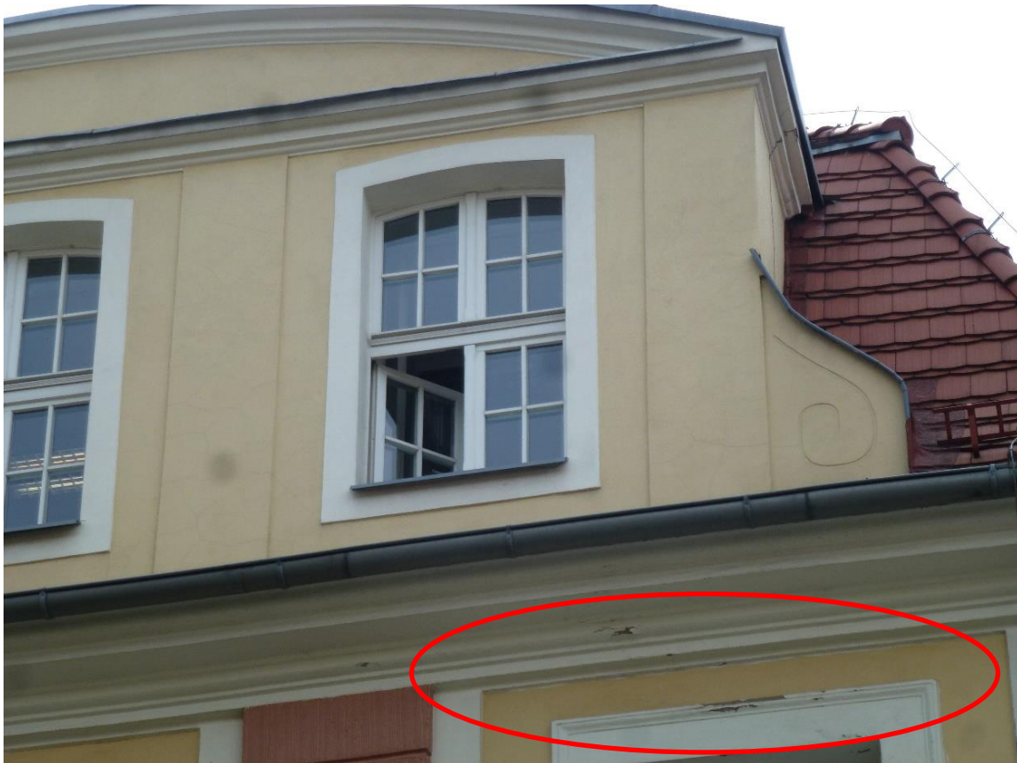
Fot.2.2 – Elewacja północna od strony ul. Tadeusza Kościuszki – miejscowe ubytki farby i tynku na gzymsie pod lukarną i na obramieniu okiennym
