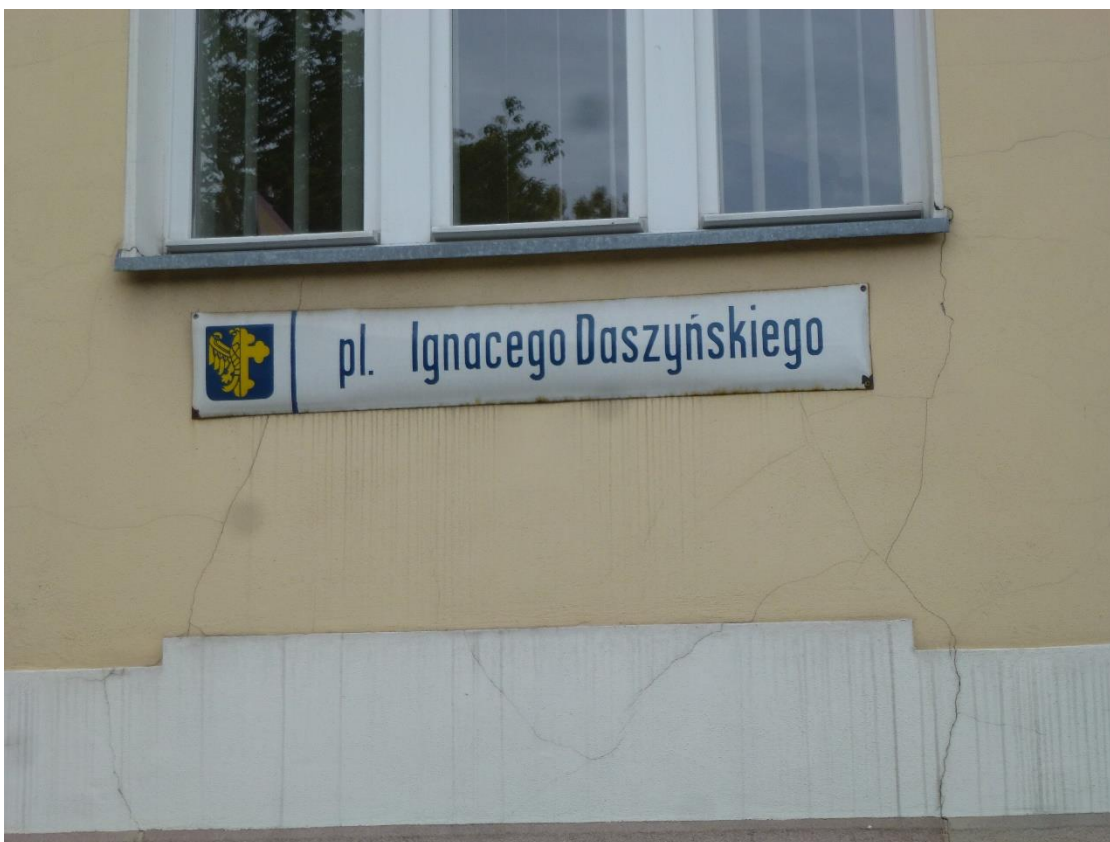
Fot.1.5- Elewacja zachodnia – widoczne spękania tynków gładkich i zacieki brudu na elewacji.
