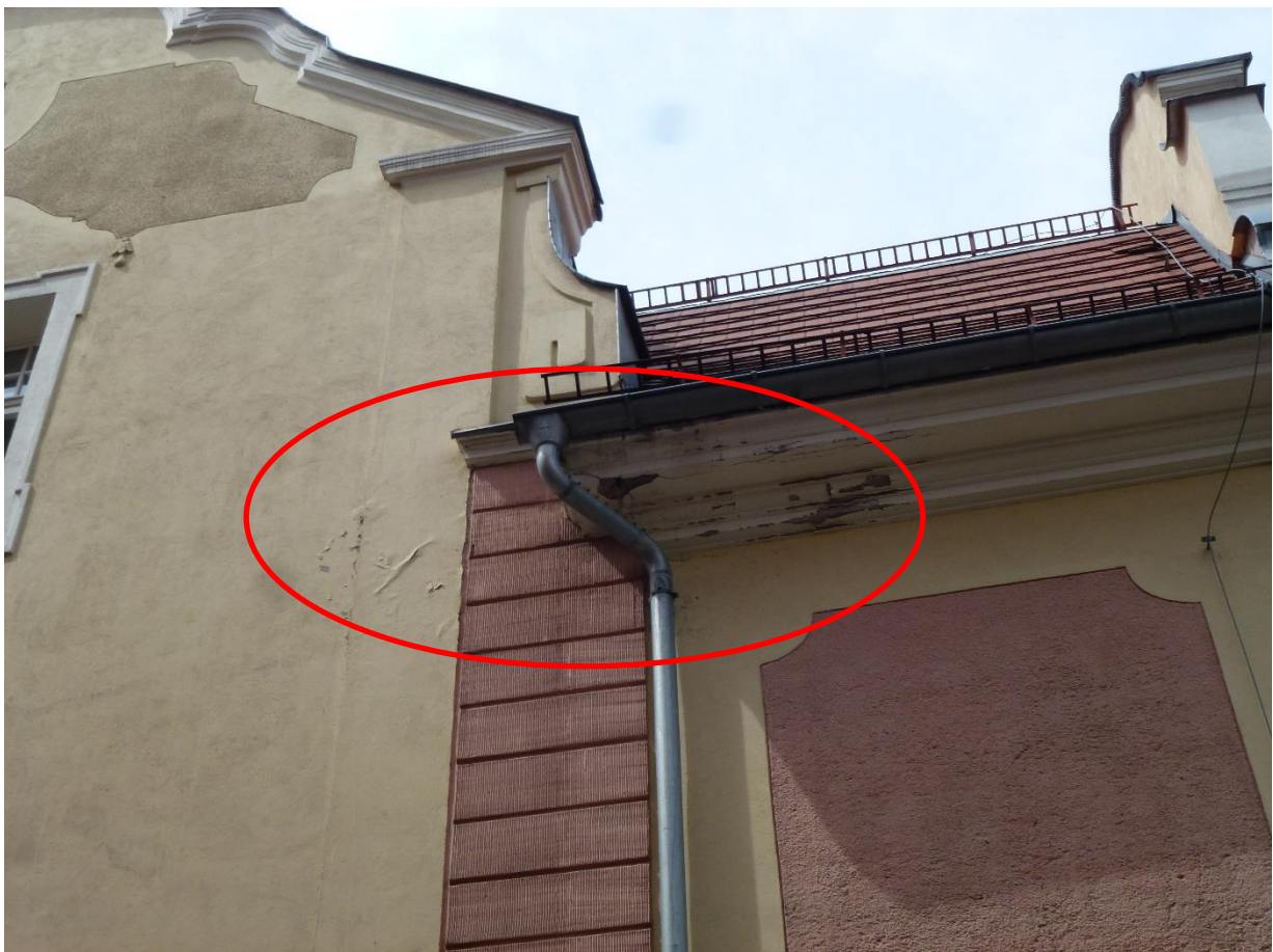
Fot.3.1 – Elewacja wschodnia ściana szczytowa – ubytki i spękania tynku oraz złuszczenia farby na gzymsie pod rynną i na ścianie gładkiej.
