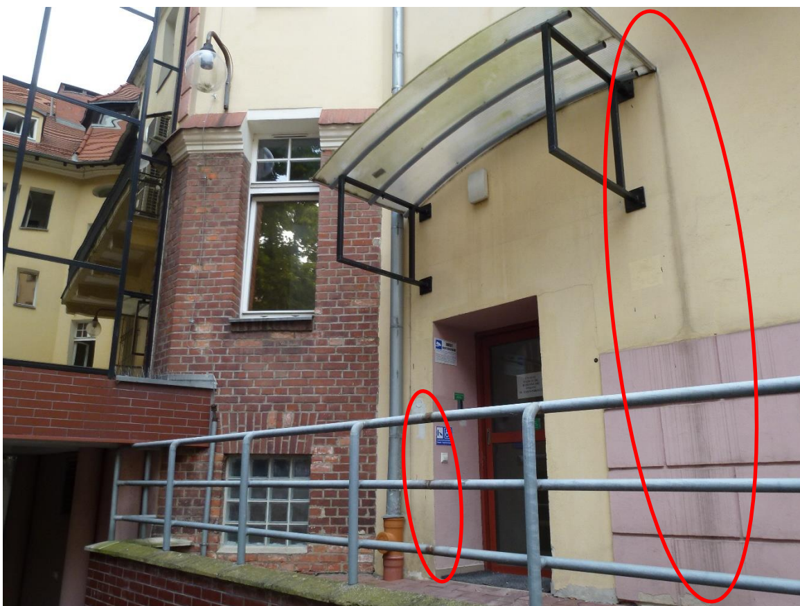
Fot.3.7 – Elewacja wschodnia od strony podwórza – brudne zacieki na ścianie miejscowo, skorodowana balustrada przy chodniku
