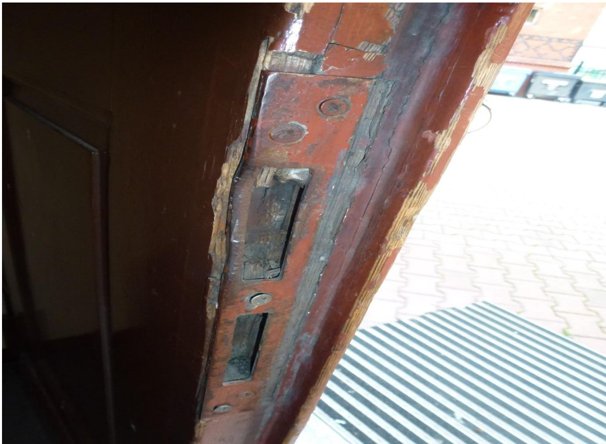
Fot.5.3 – Elewacja południowo-wschodnia od podwórza – drzwi wejściowe w złym stanie technicznym , w zbliżeniu widoczne zniszczone okucia.
