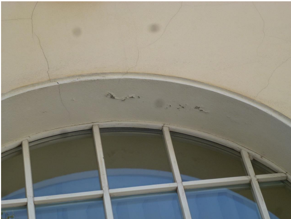
Fot.2.4 – Elewacja północna od strony ul. Tadeusza Kościuszki – miejscowe złuszczenia farby i spękania włoskowate tynku na powierzchni ścian elewacji.
