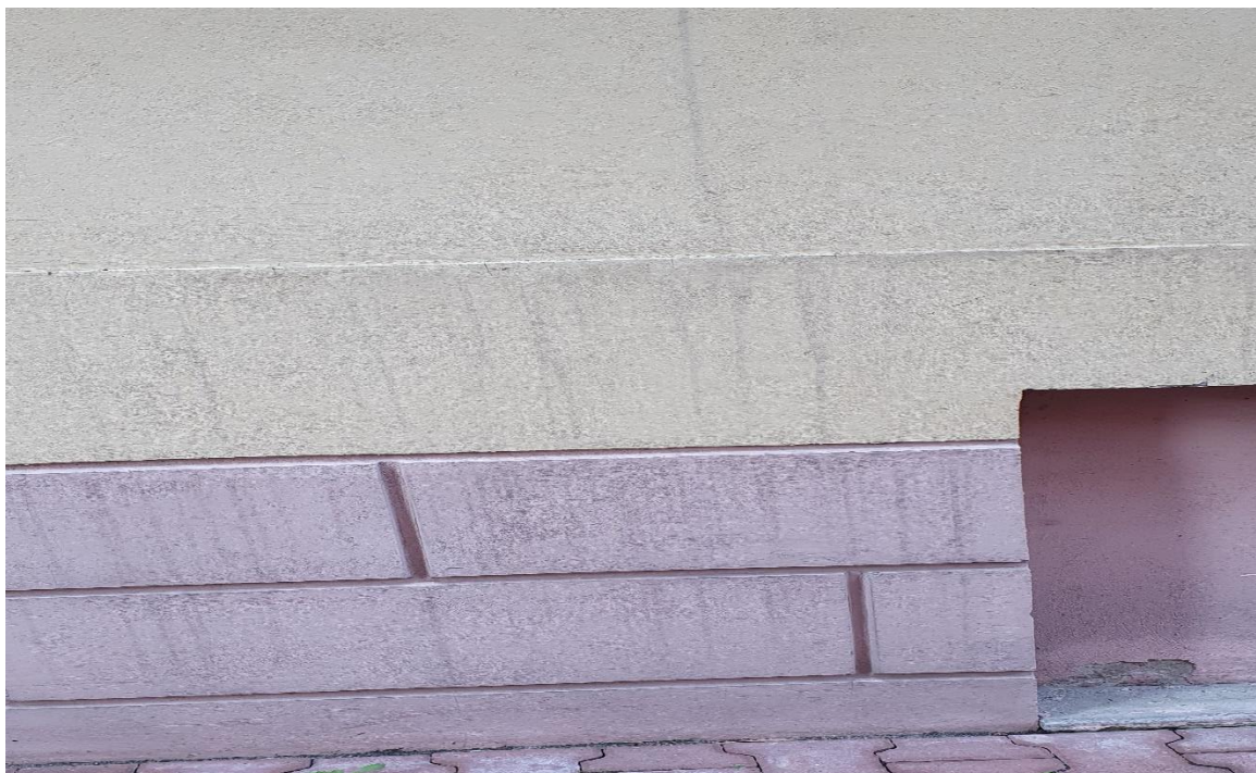
Fot.4.2 – Elewacja południowa od podwórza – brudne zacieki na cokole oraz złuszczenia i ubytki farby.
