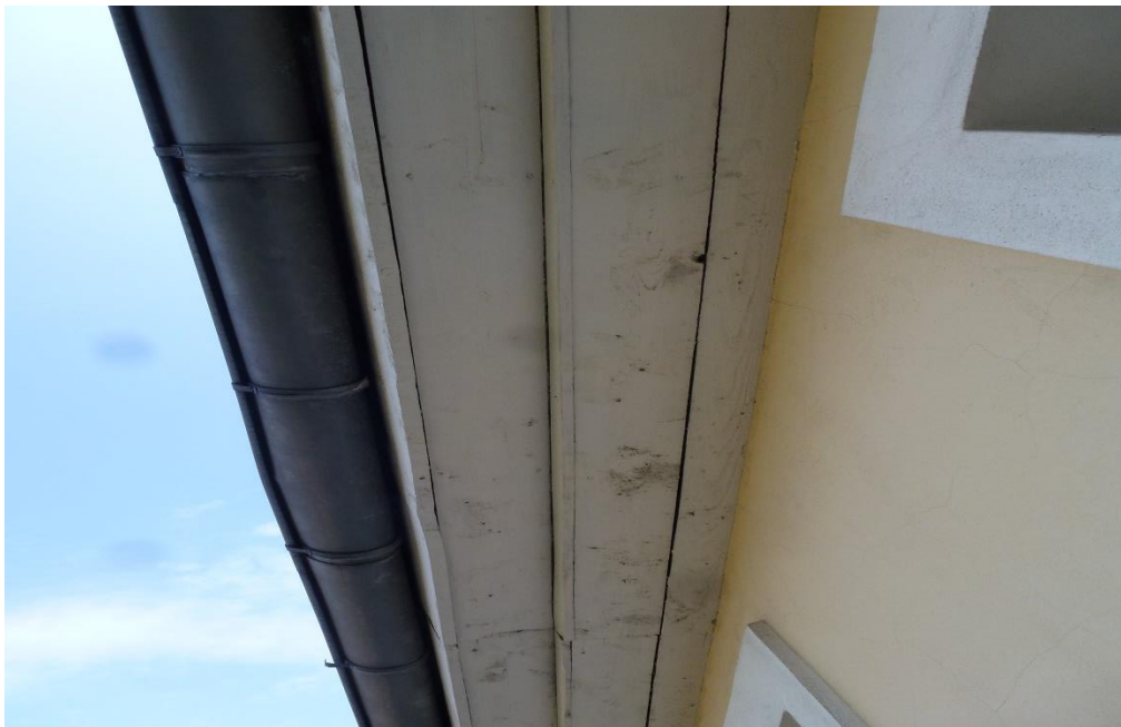
Fot.1.12 – Elewacja zachodnia – ubytki farby na gzymsie drewnianym pod okapem.
