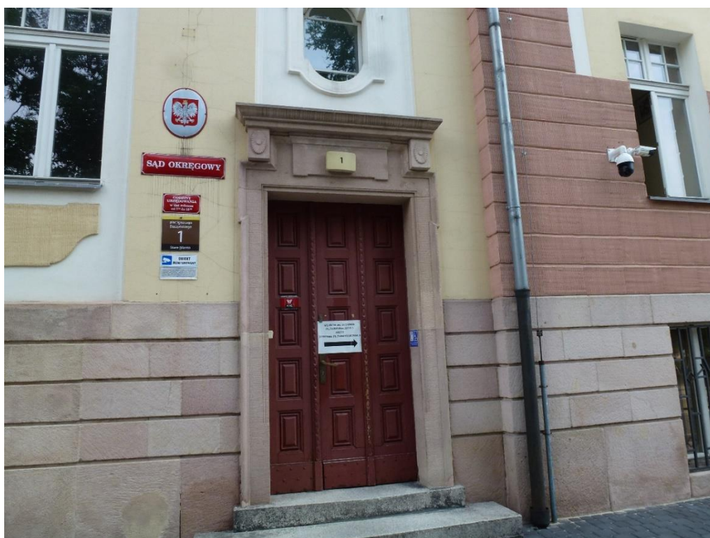
Fot. 1.1 – Elewacja zachodnia portal wejścia do budynku – drzwi wymagające wymiany zniszczonych okuć i renowacji powierzchni, elementy portalu z piaskowca różowego wymagają oczyszczenia z brudu i impregnacji hydrofobowej.
