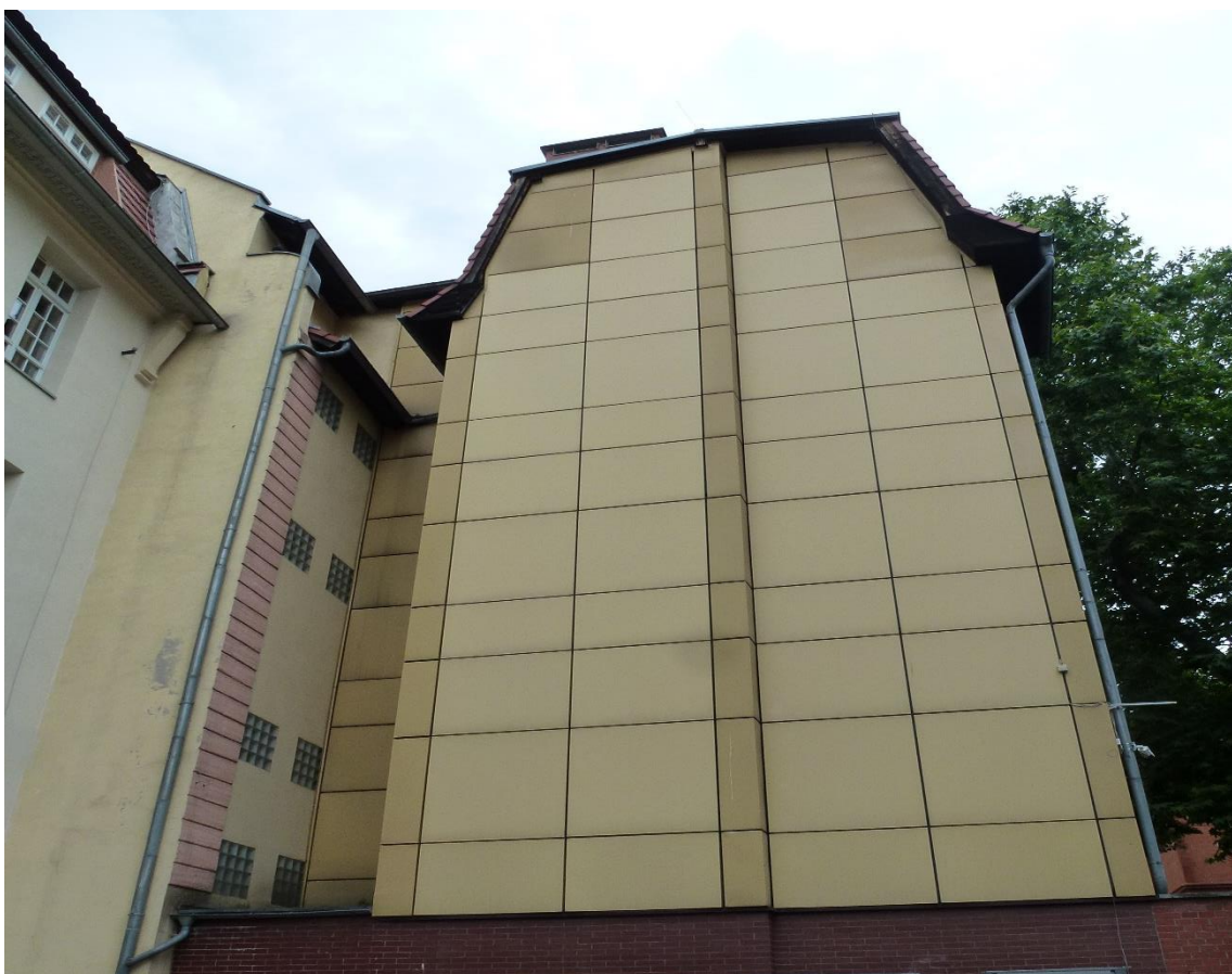
Fot.9.0 – Elewacja południowa od strony parkingu – zabrudzone panele z blachy malowanej proszkowo, ubytki farby i spękania tynków na elewacji tynków gładkich.
