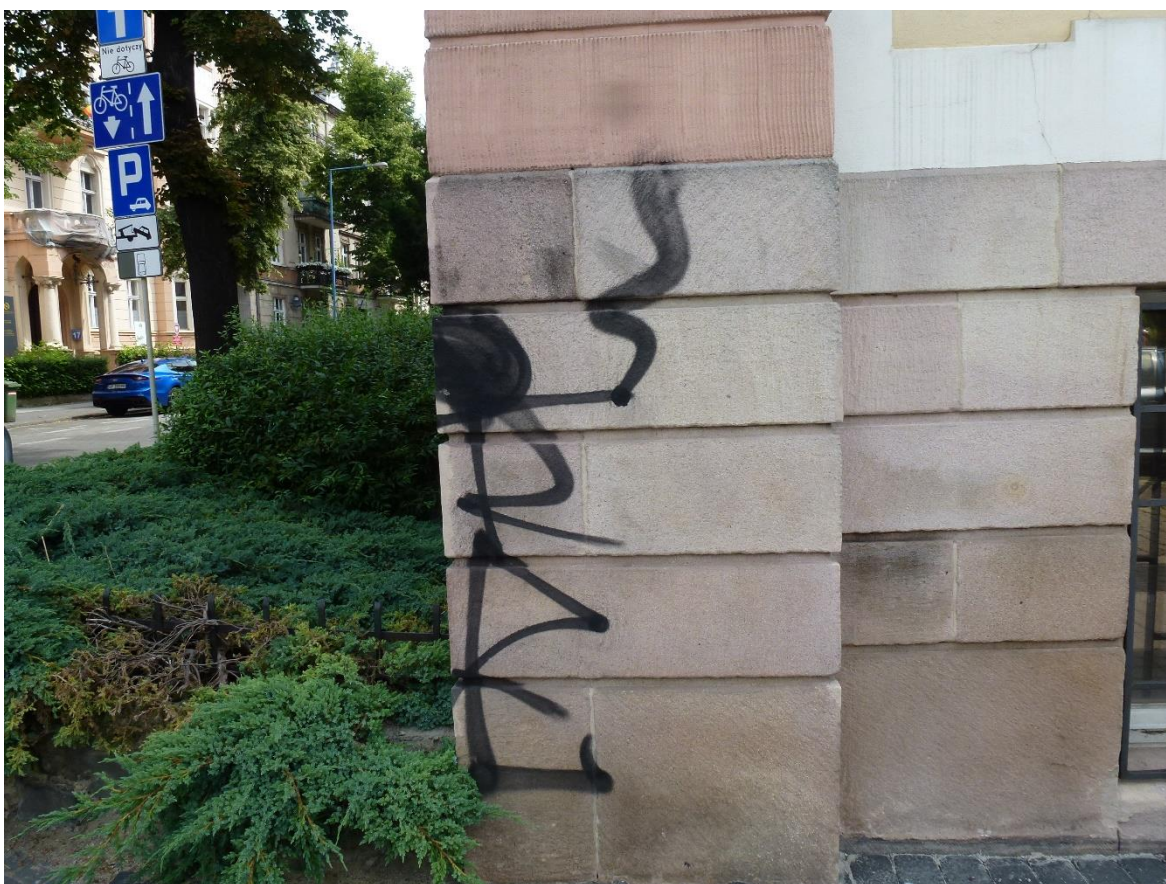
Fot. 1.7- Elewacja zachodnia – graffiti i plamy na cokole z piaskowca różowego.
