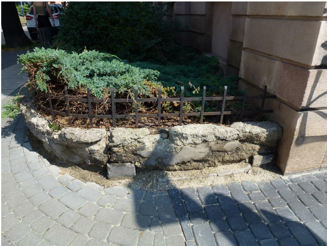
Fot.2.10 – Elewacja północna od strony ul. Tadeusza Kościuszki - uszkodzony na całej długości cokół betonowy klombu zieleni, skorodowany powierzchniowo stalowy płatek klombu.
