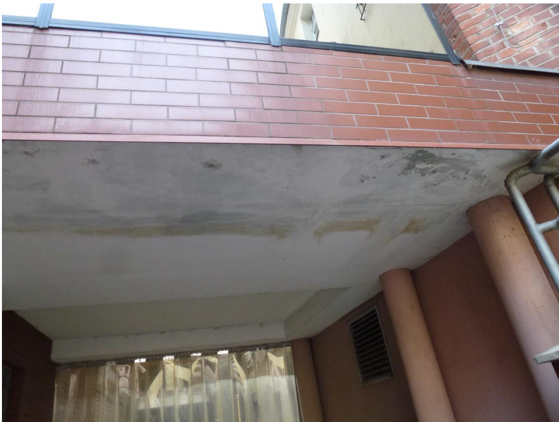
Fot.7.2 – Elewacja północna dobudówki – zacieki i złuszczenia farby na suficie stropu łącznika dobudówki.
