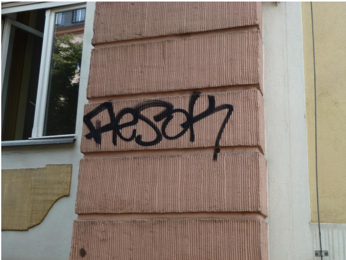
Fot.2.6 – Elewacja północna od strony ul. Tadeusza Kościuszki – graffiti na tynku ciągnionym pilastru
