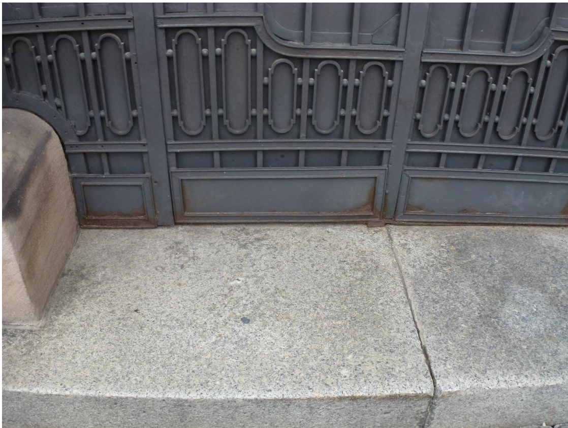
Fot.1.10 – Elewacja zachodnia – skorodowane drzwi w strefie progu.
