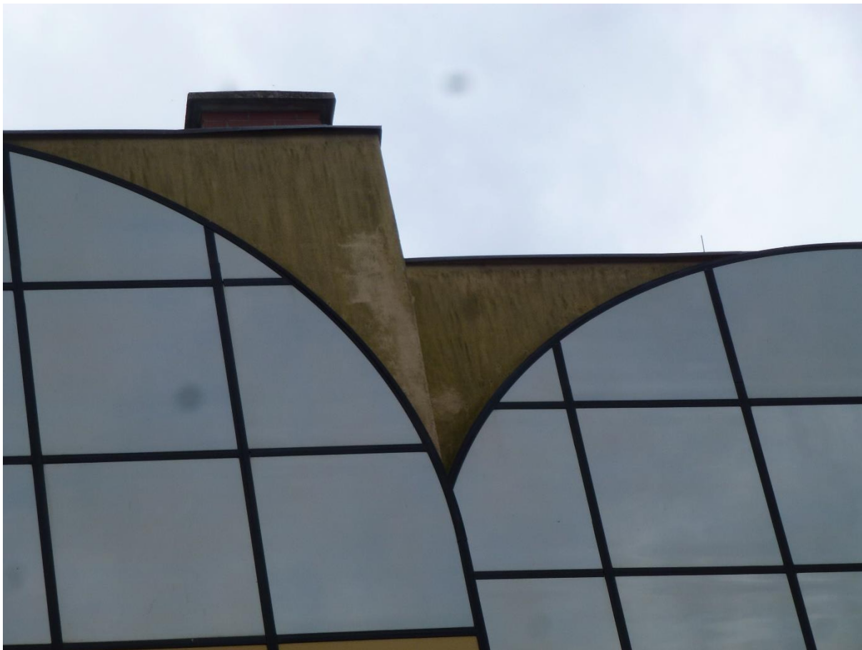
Fot.7.1 – Elewacja północna dobudówki – ściany tynków gładki powyżej oszklenia widoczne zacieki brudu oraz widoczne zielone glony na powierzchni tynku
