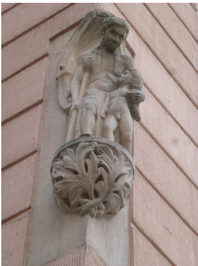
Fot.1.15 – Elewacja zachodnia – rzeźba mężczyzny i chłopiec z piaskowca – brak ubytków w kamieniu, widoczny jedynie brud, sadza i zacieki zwłaszcza w górnej części rzeźby – wymaga oczyszczenia oraz impregnacji hydrofobowej
