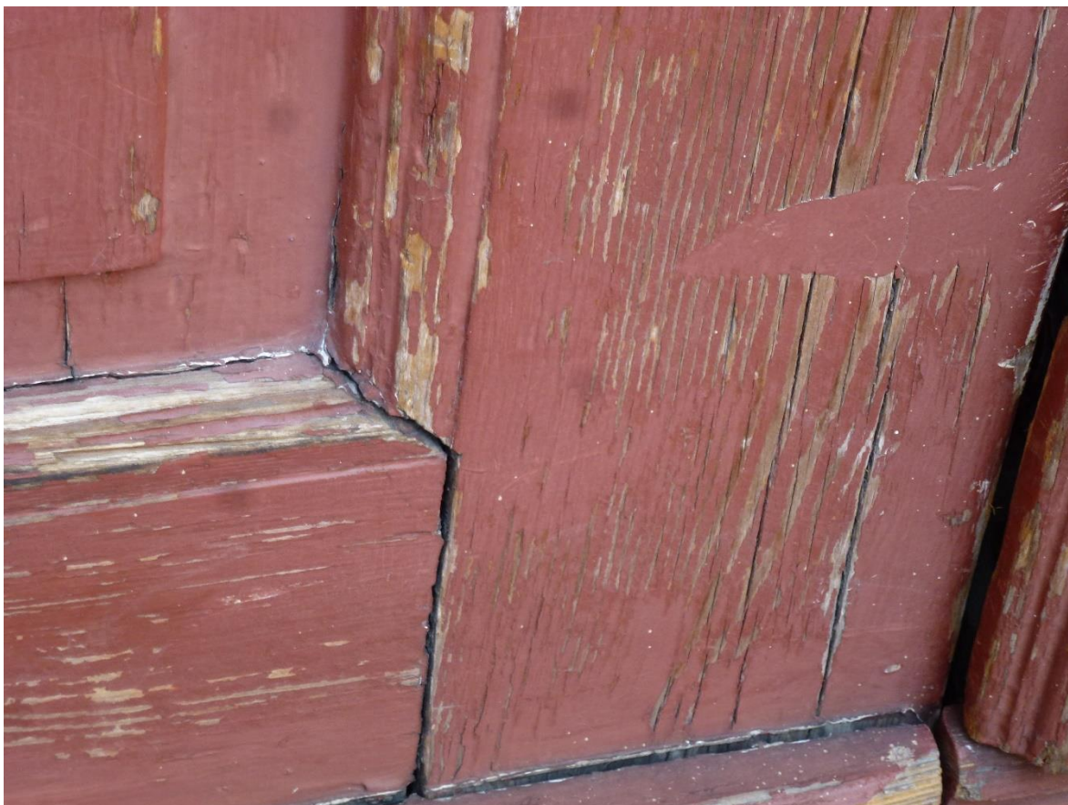
Fot.5.2 – Elewacja południowo-wschodnia od podwórza – drzwi wejściowe w złym stanie technicznym , w zbliżeniu widoczne spękania i zeschnięcia elementów.
