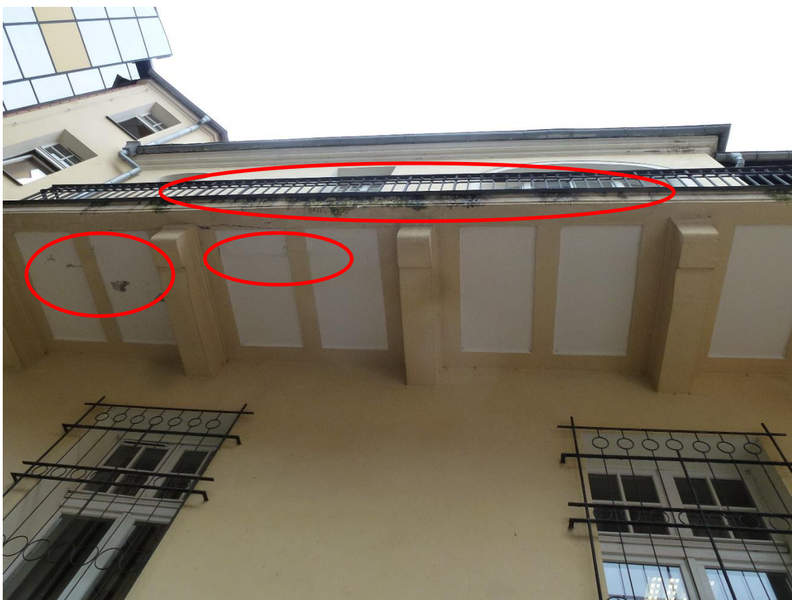
Fot.3.3 – Elewacja wschodnia ściana od podwórza – ubytki i spękania i spuchlizny tynku na płycie balkonowej oraz zacieki i ubytki farby na policzku płyty balkonowej, nieszczelna obróbka blacharska okapu płyty balkonowej.
