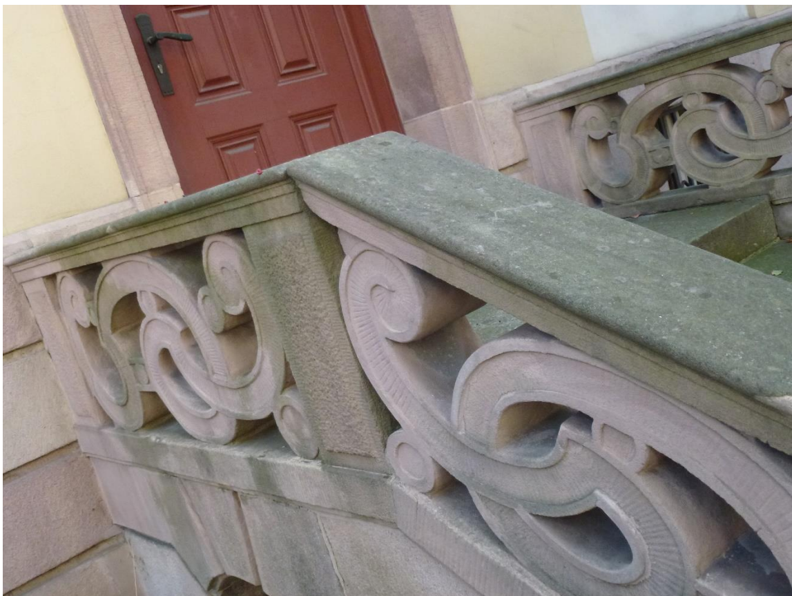
Fot.2.9 – Elewacja północna od strony ul. Tadeusza Kościuszki – zacieki brudu z sadzą na kamiennych elementach z piaskowca przy schodach.
