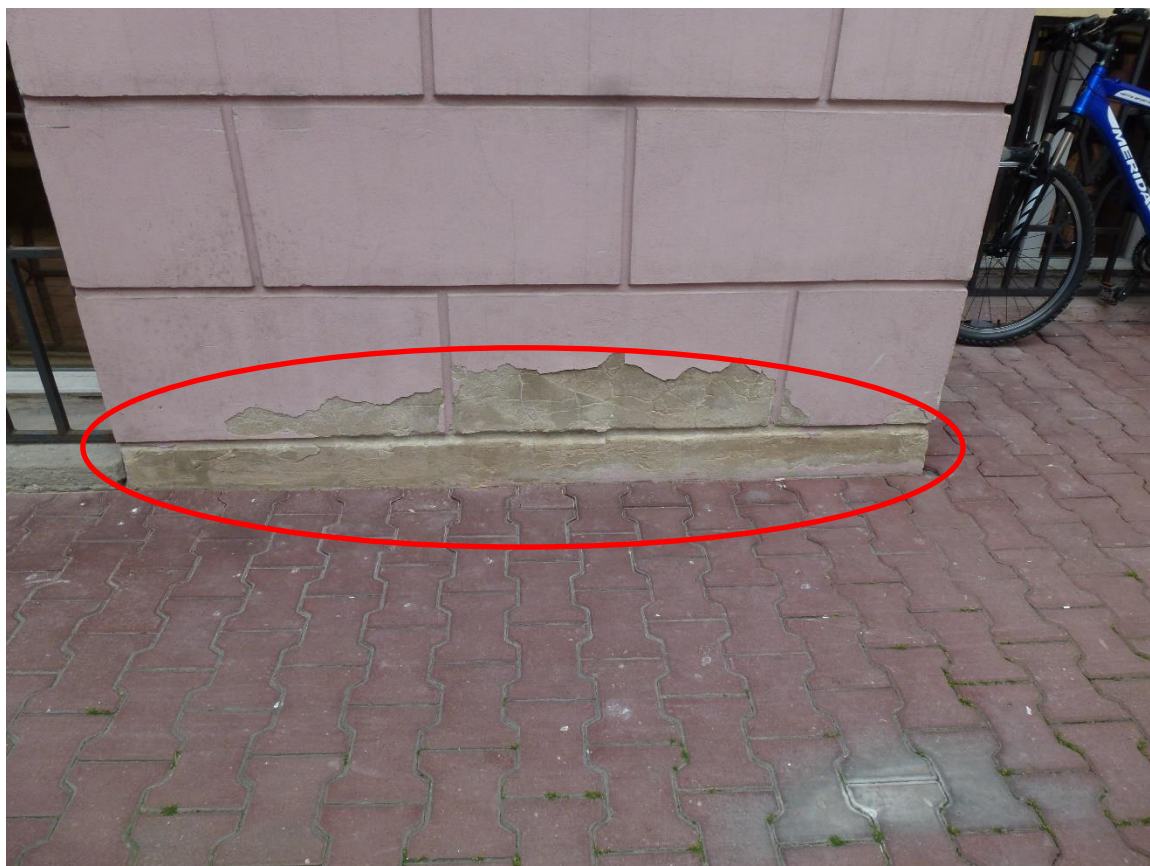
Fot.3.5 – Elewacja wschodnia od strony podwórza – ubytki farby na cokole boniowanym w strefie przyziemia.
