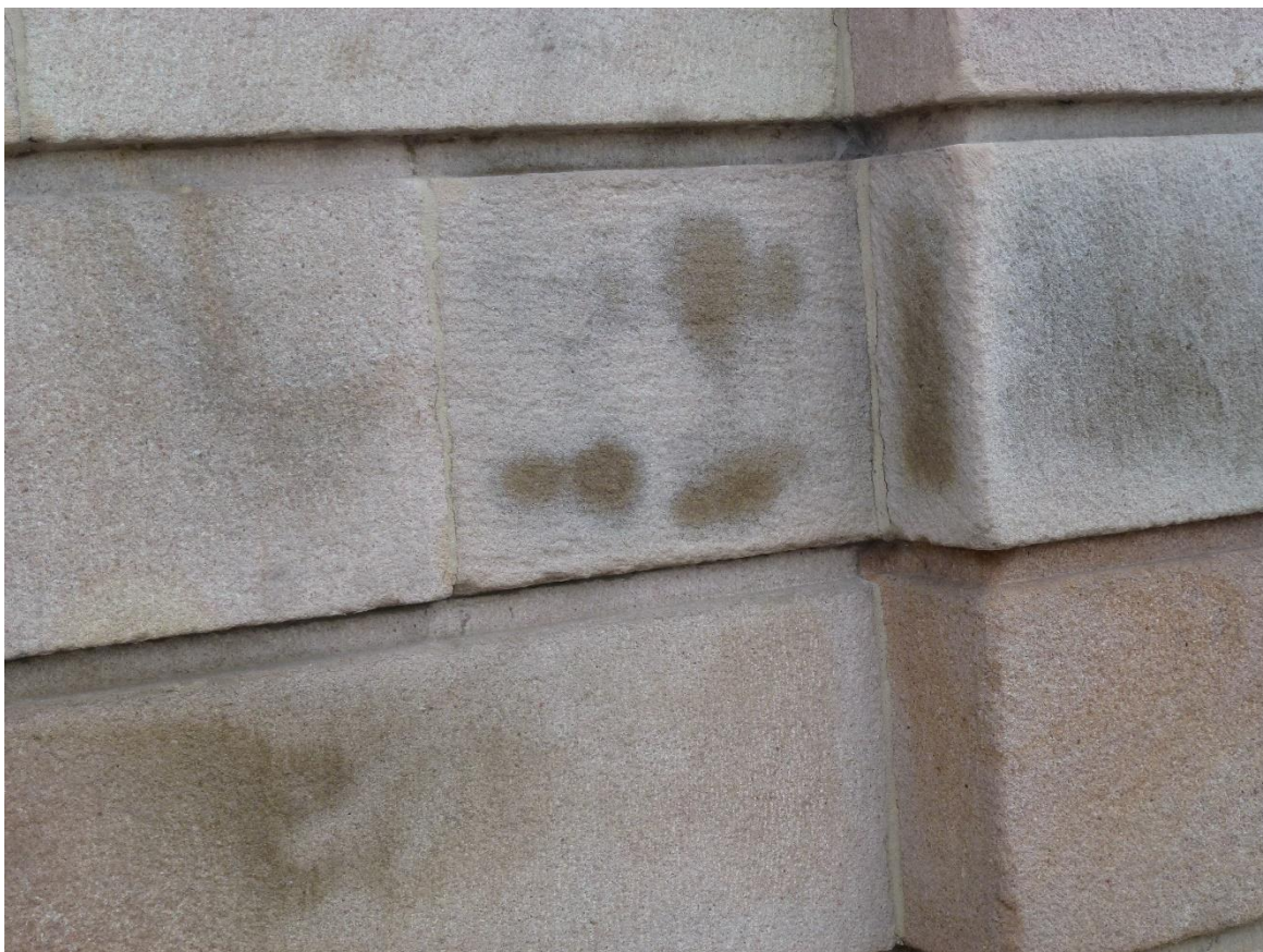
Fot.1.6- Elewacja zachodnia – plamy na cokole z piaskowca różowego.
