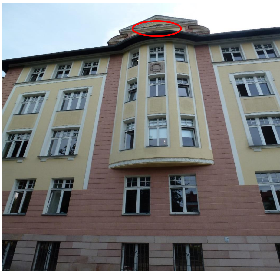
Fot. 1.3.- Elewacja zachodnia – wykusz na elewacji budynku nr 2 – widoczne spękania włoskowate tynku gładkim, ubytki tynku i farby na gzymsie pod lukarną.
