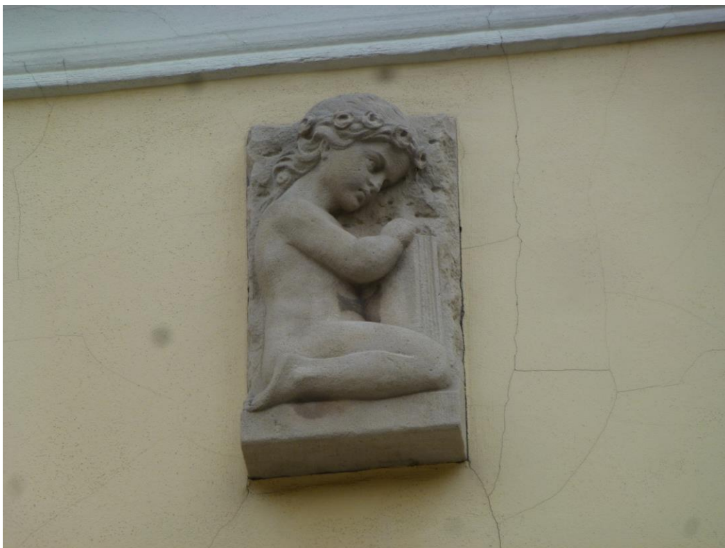
Fot. 1.14 – elewacja zachodnia – jedna z kilku płaskorzeźb stan dobry brak ubytków w kamieniu wymaga jedynie oczyszczenia piaskowca i impregnacji hydrofobowej kamienia – wokół płaskorzeźby spękania na tynkach gładkich
