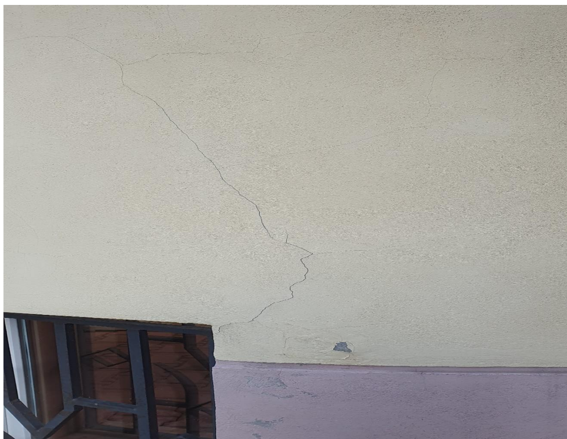
Fot.4.3 – Elewacja południowa od podwórza – spękania oraz złuszczenia i ubytki farby na tynkach gładkich i cokole wykuszu.
