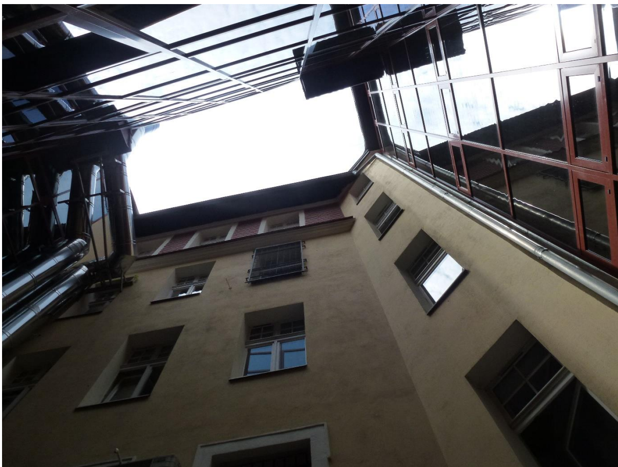
Fot.6.2 – Elewacja zachodnia (patio) – brudne zacieki na tynkach gładkich elewacji, uszkodzone i nieszczelne rynny, podsufitka drewniana okapu wymaga oczyszczenia i malowania powierzchni oraz wymiany miejscowo uszkodzonych desek.
