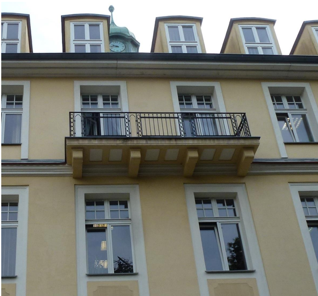
Fot.1.9 – Elewacja zachodnia – nieszczelna obróbka blacharska powodująca zalewanie płyty balkonowej.
