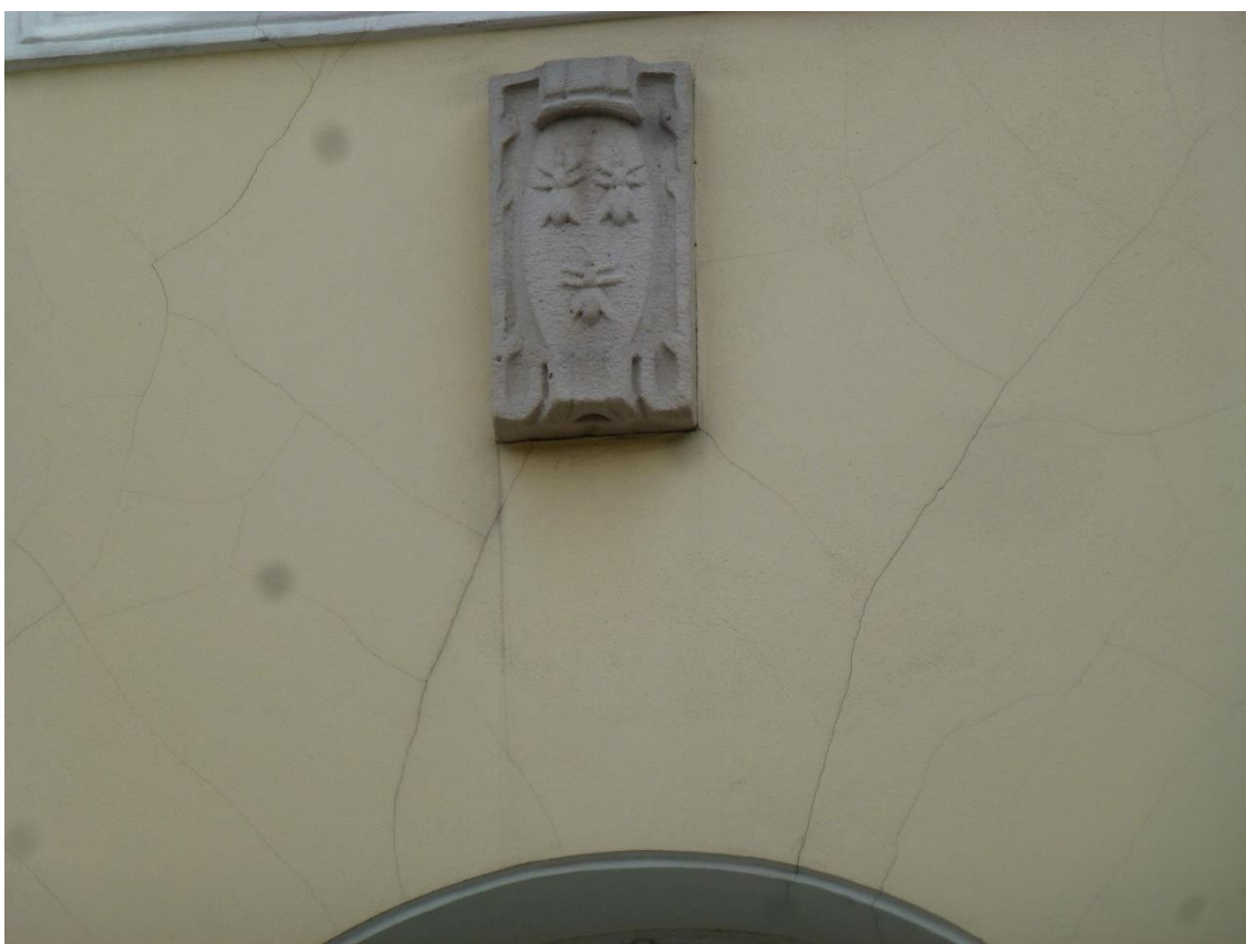
Fot.2.5 – Elewacja północna od strony ul. Tadeusza Kościuszki –spękania włoskowate tynku na powierzchni ścian elewacji.
