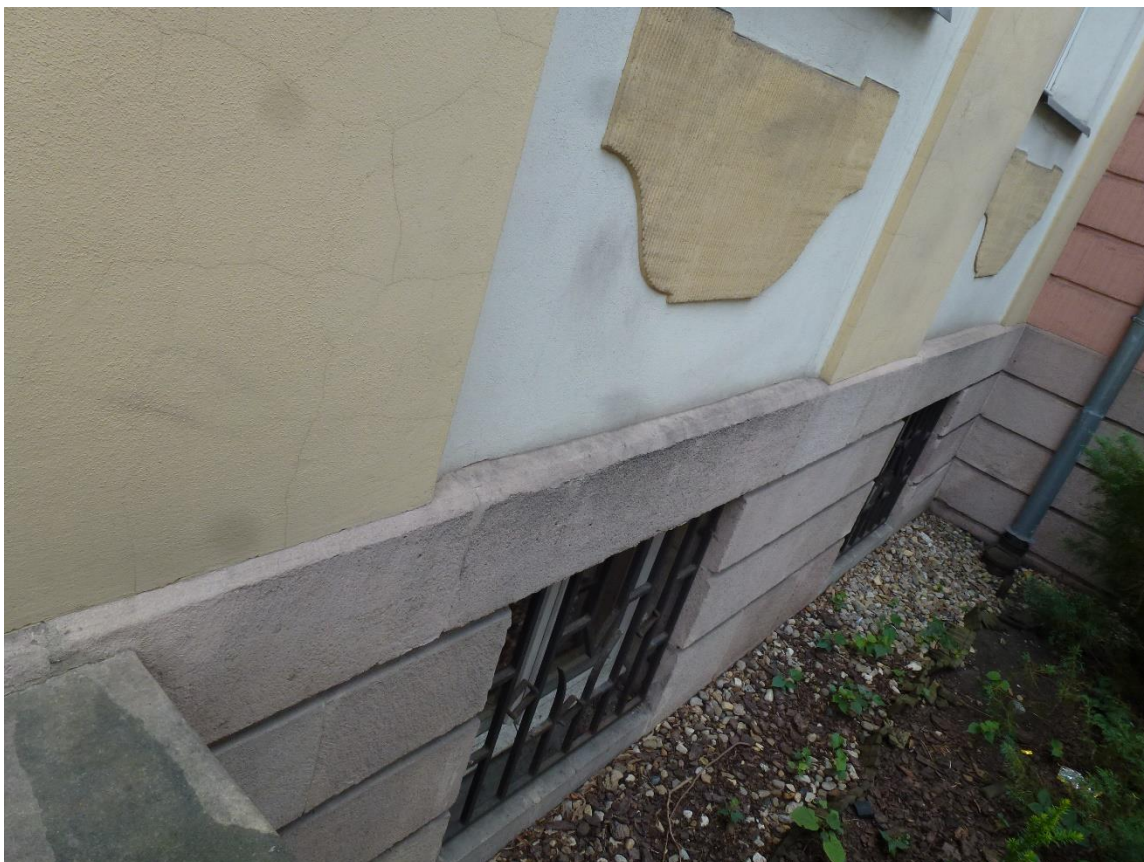
Fot.2.7 – Elewacja północna od strony ul. Tadeusza Kościuszki – spękania włoskowate na tynkach gładkich oraz brudne tynki gładkie i piaskowiec różowy cokołu.
