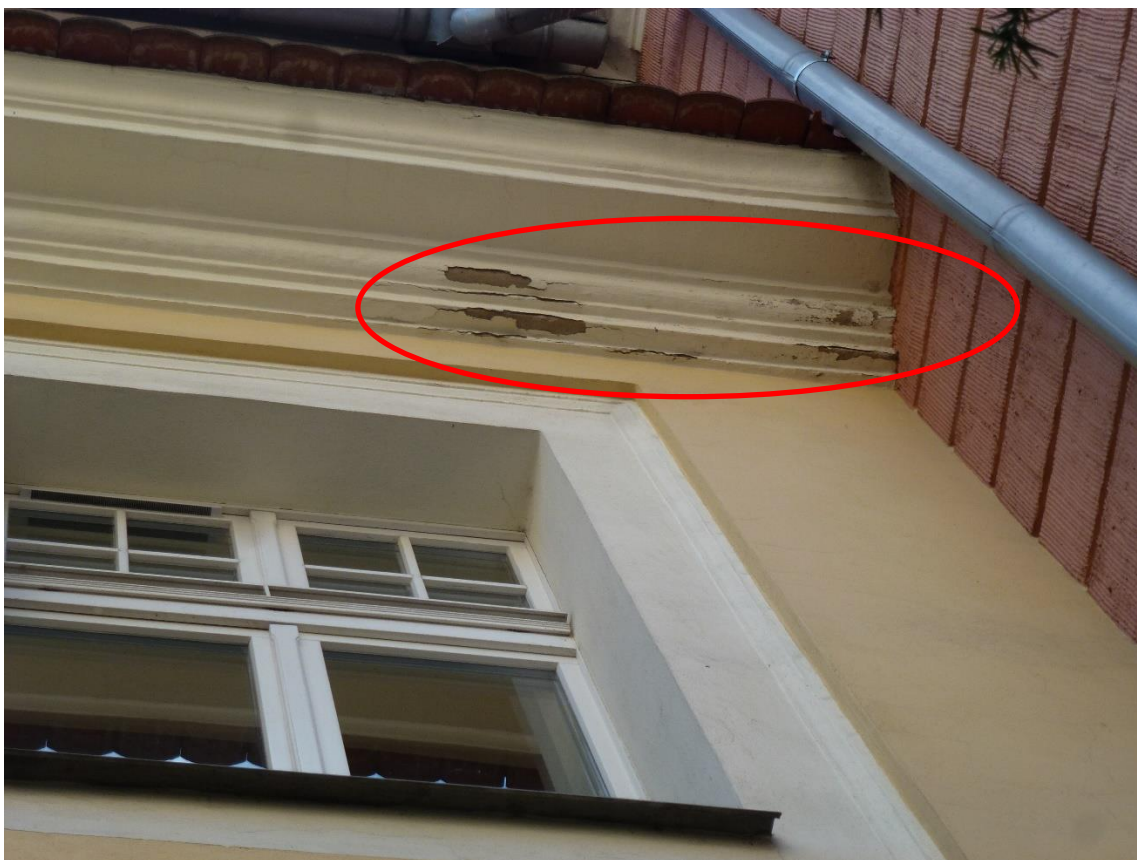
Fot.2.3 – Elewacja północna od strony ul. Tadeusza Kościuszki – miejscowe ubytki farby i tynku na gzymsie
