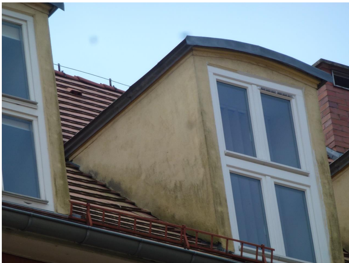
Fot.2.1 – Elewacja północna od strony ul. Tadeusza Kościuszki – naloty wilgoci i glonów na ścianach lukarn dachowych
